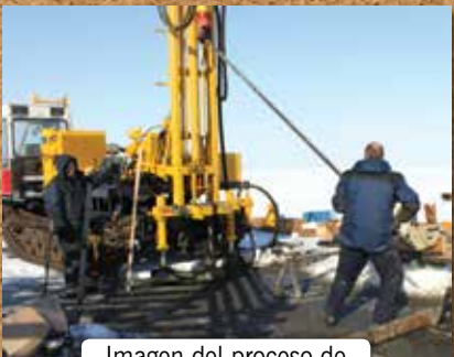
Imagen del proceso de perforación
